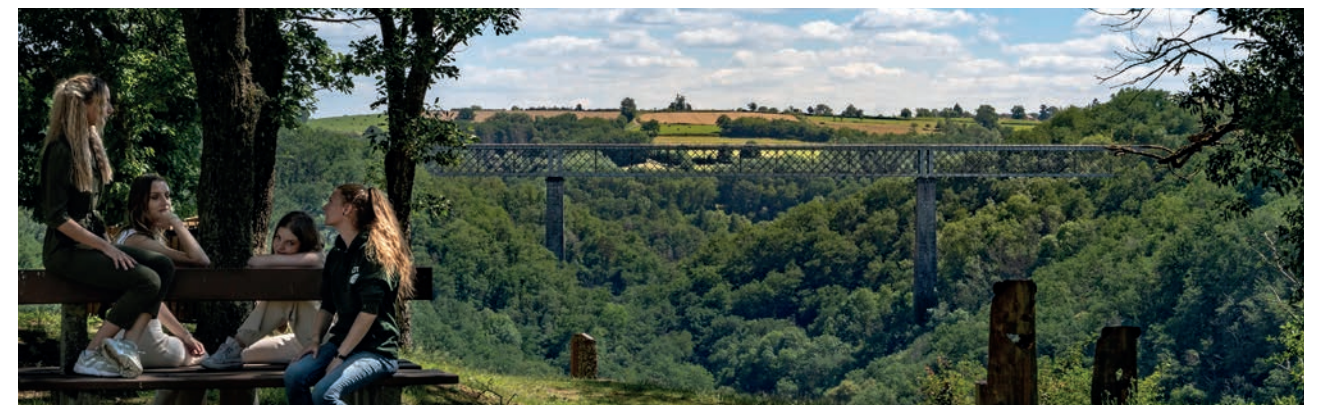
Viaduc de la Tardes
